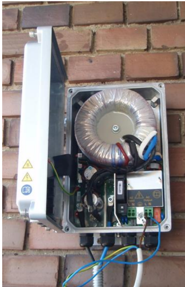
13. ábra A 48 / 230 V-os inverter
