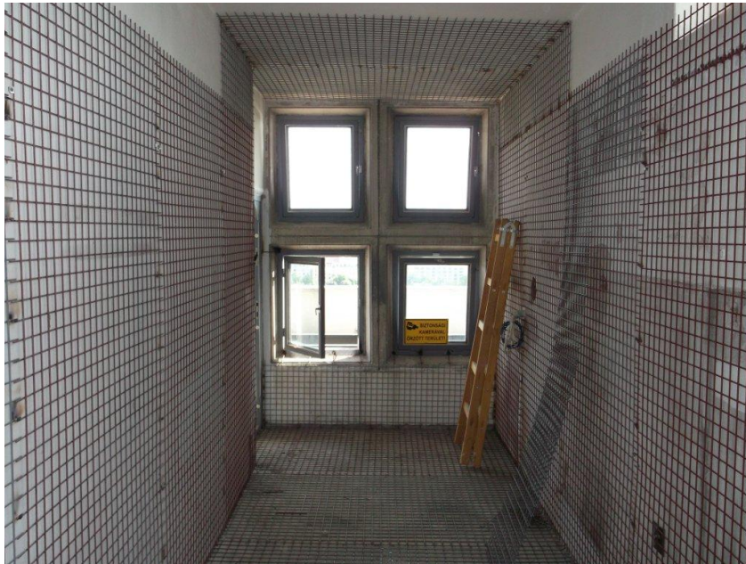
8. ábra A bemutató állomás helyisége a Faraday-kalickával
